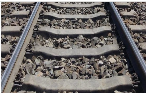
图 11.4-1 铁道弹条减振示意图示意图
