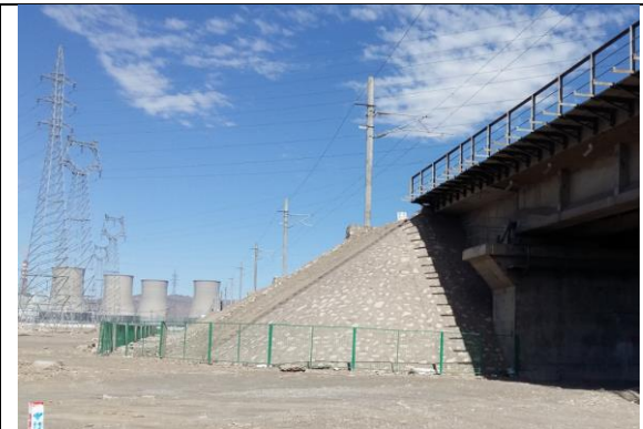
图 5.4-2 工程边坡防护示意图（二）
