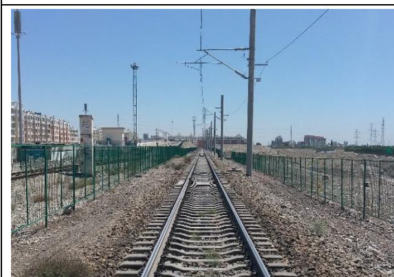
图 5.4-5 工程线路两侧防护示意图
