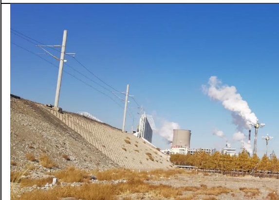
图 5.4-3 工程边坡防护示意图（三）
