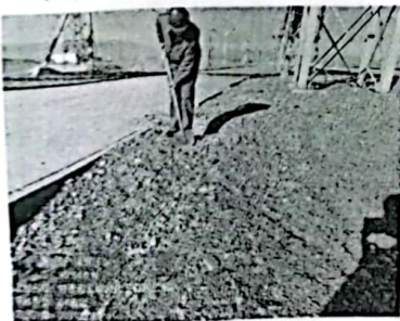
6#表层: 成品罐区北侧
