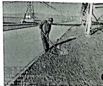
6#表层: 成品罐区北侧
