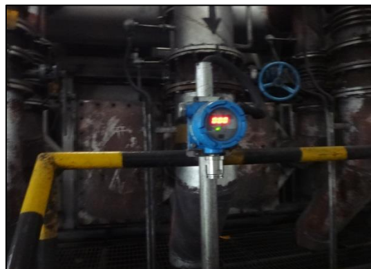
加热炉处 CO 监测仪现状
