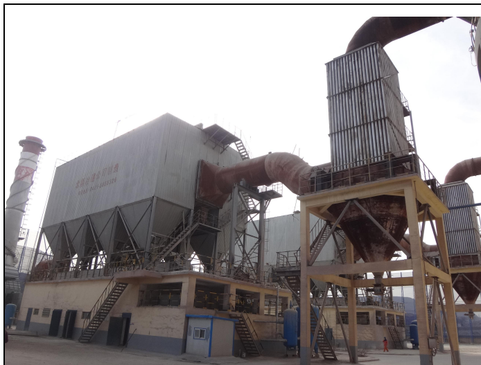
图 1 窑尾多管式+脉冲除尘设备
