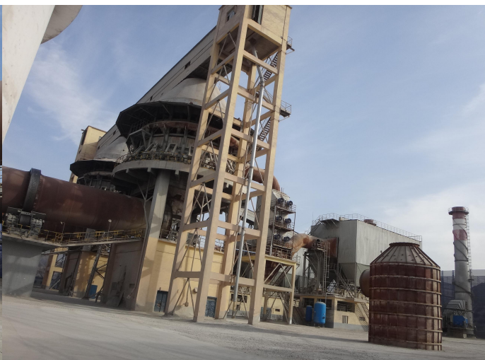
图 10 石灰窑预热器
