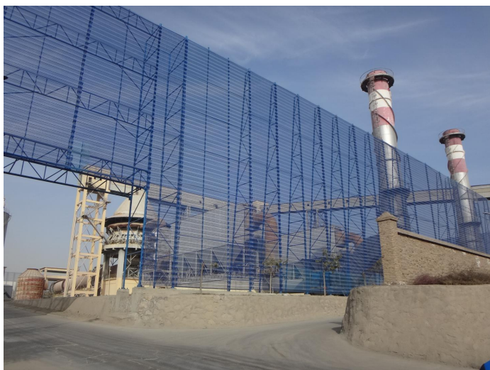
图 11 石灰窑厂区抑尘网
