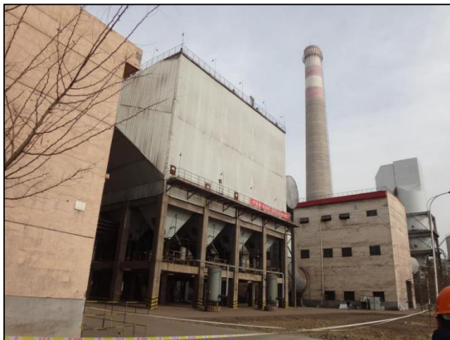
烧结机机头电除尘器
