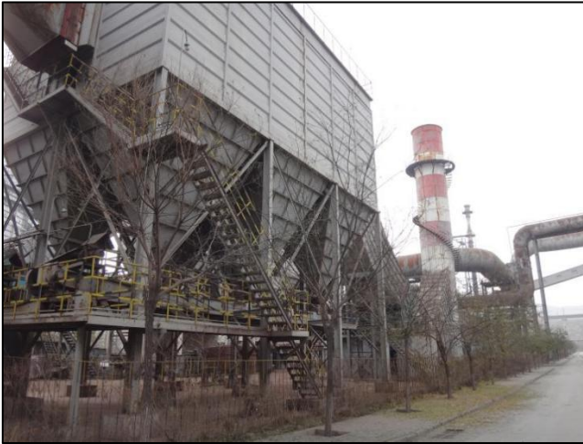
转炉二次烟气布袋除尘器
