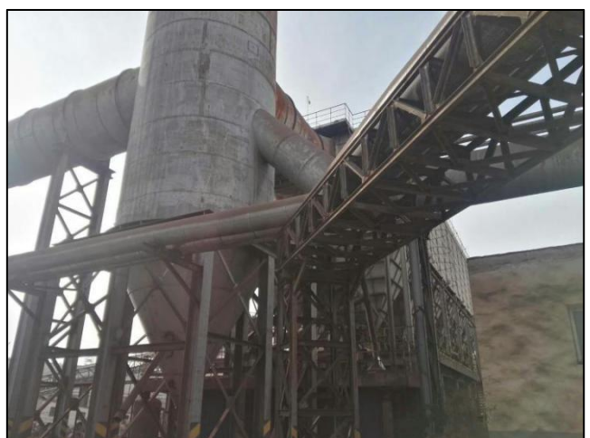
烧结机机尾重力除尘器
