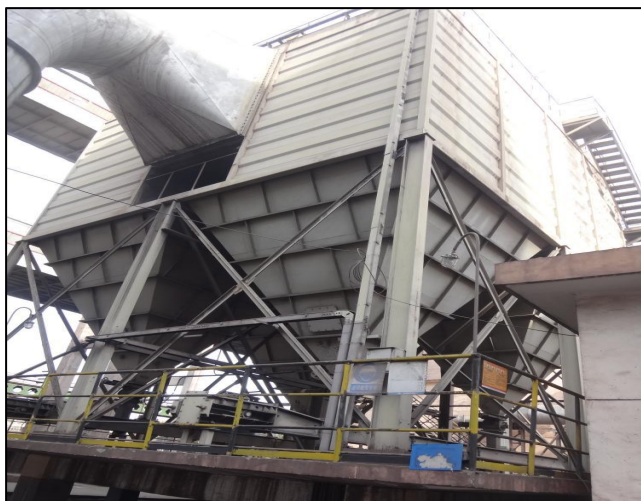
燃料破碎系统布袋除尘器
