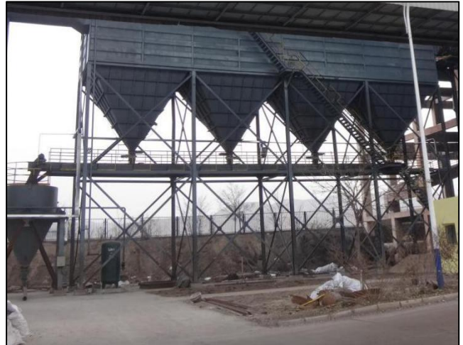
钢包精炼炉布袋除尘器
