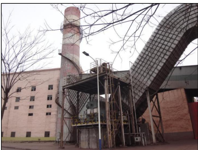
焦、矿槽及上料系统袋式除尘器
