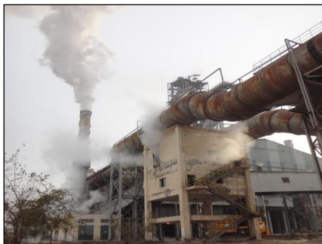
出铁场蒸汽排气筒
