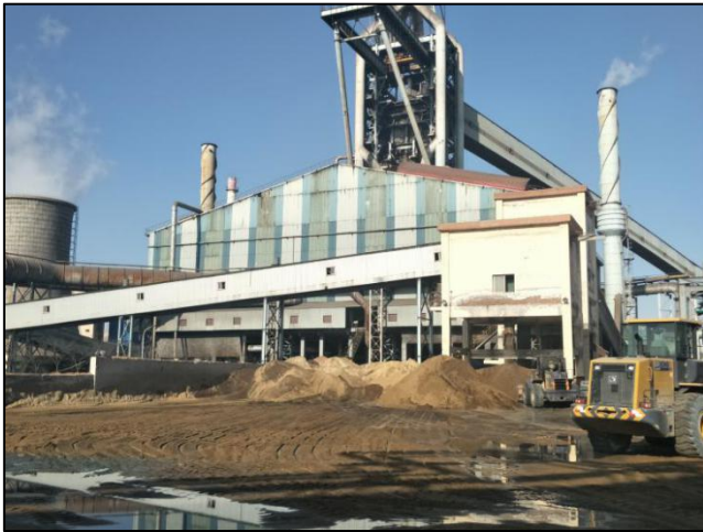
高炉渣水冲渣设施及临时堆存场
