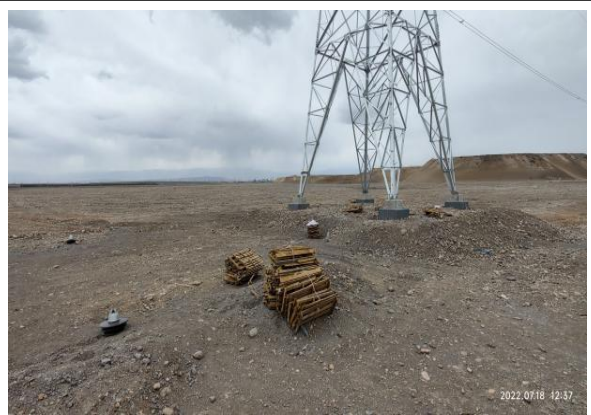
7月塔基及施工场地区土地整治
