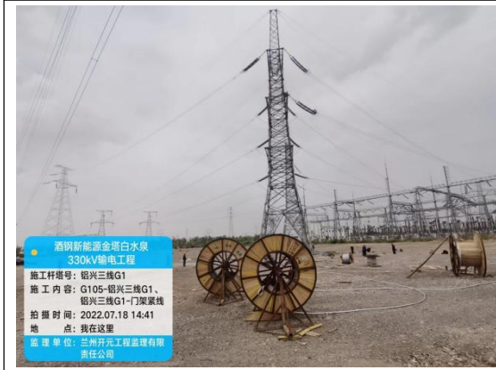
7月牵张场区施工
