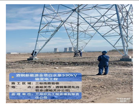
8月塔基及施工场地区土地整治
