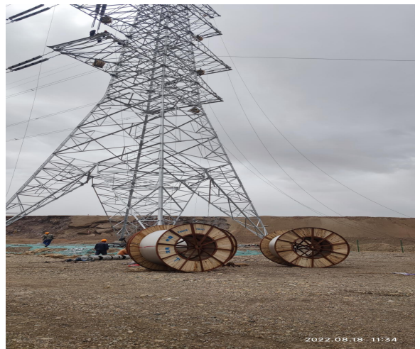
8月塔基及施工场地区苫盖措施
