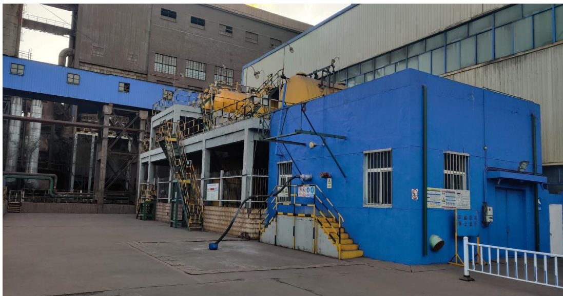
图 3-7 选矿厂储罐及储槽
