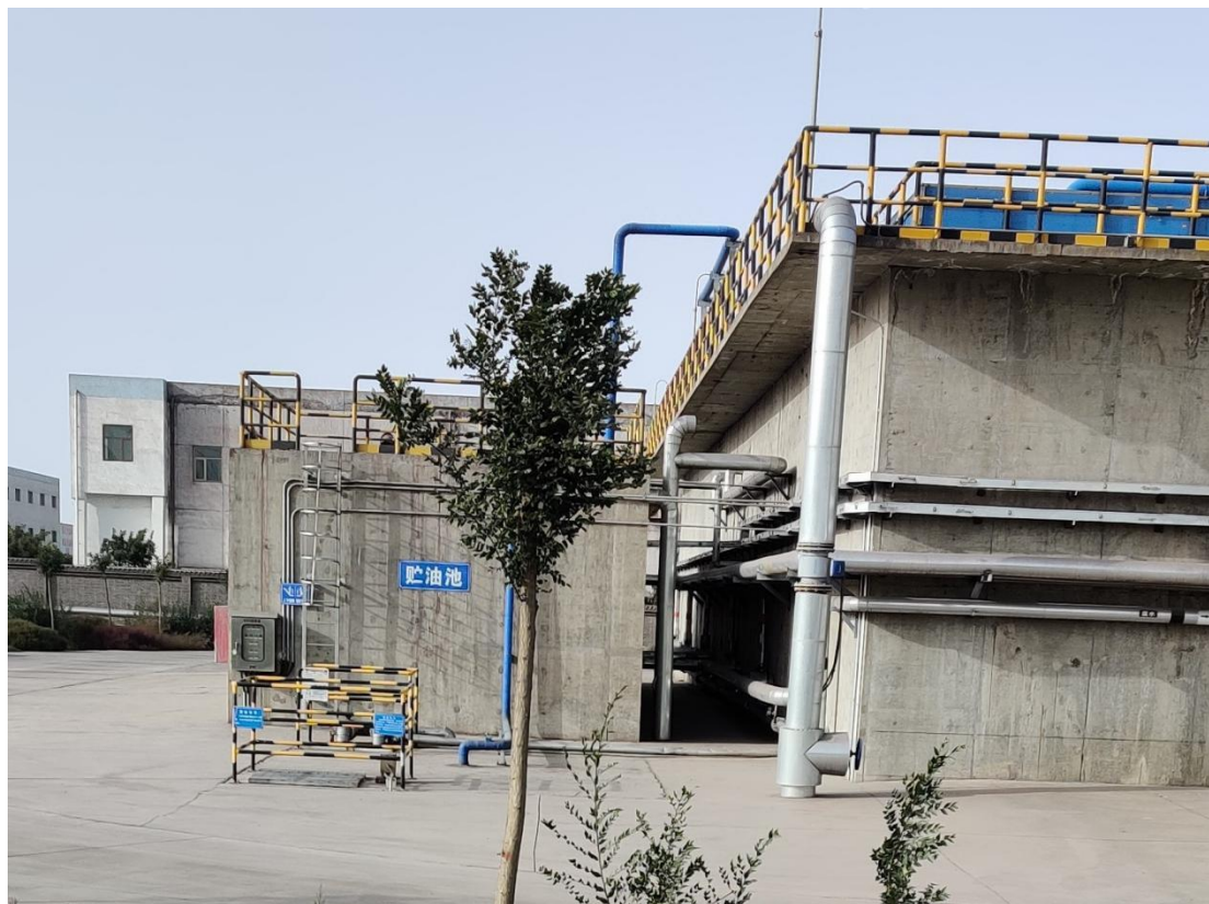
(酚氰废水站贮油池)
