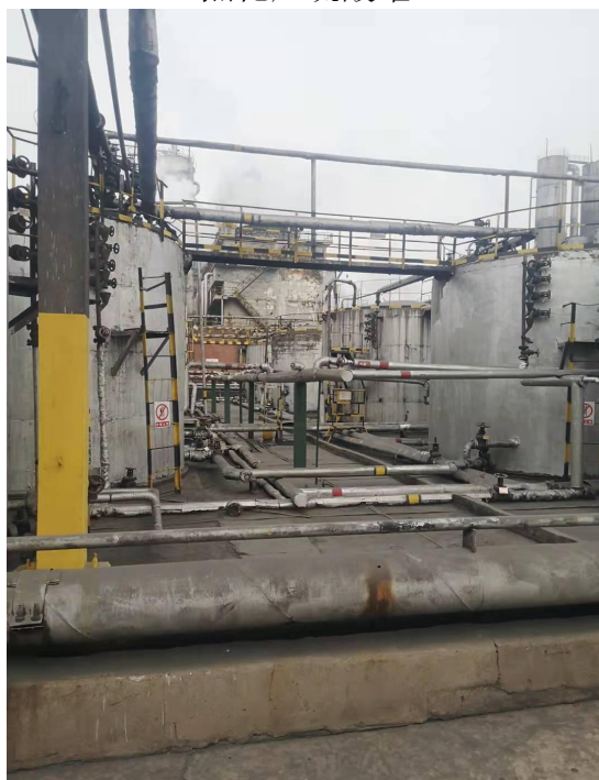
(焦化厂综合槽区)
