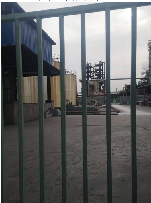
(焦化厂粗笨罐区)
