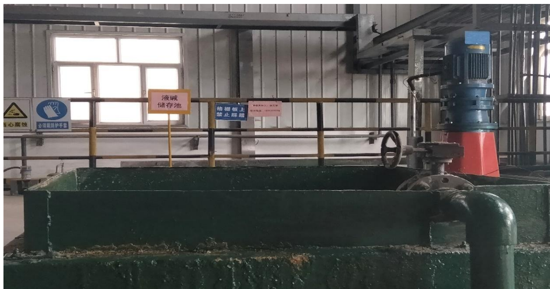
（酚氰废水站液碱储存池）
