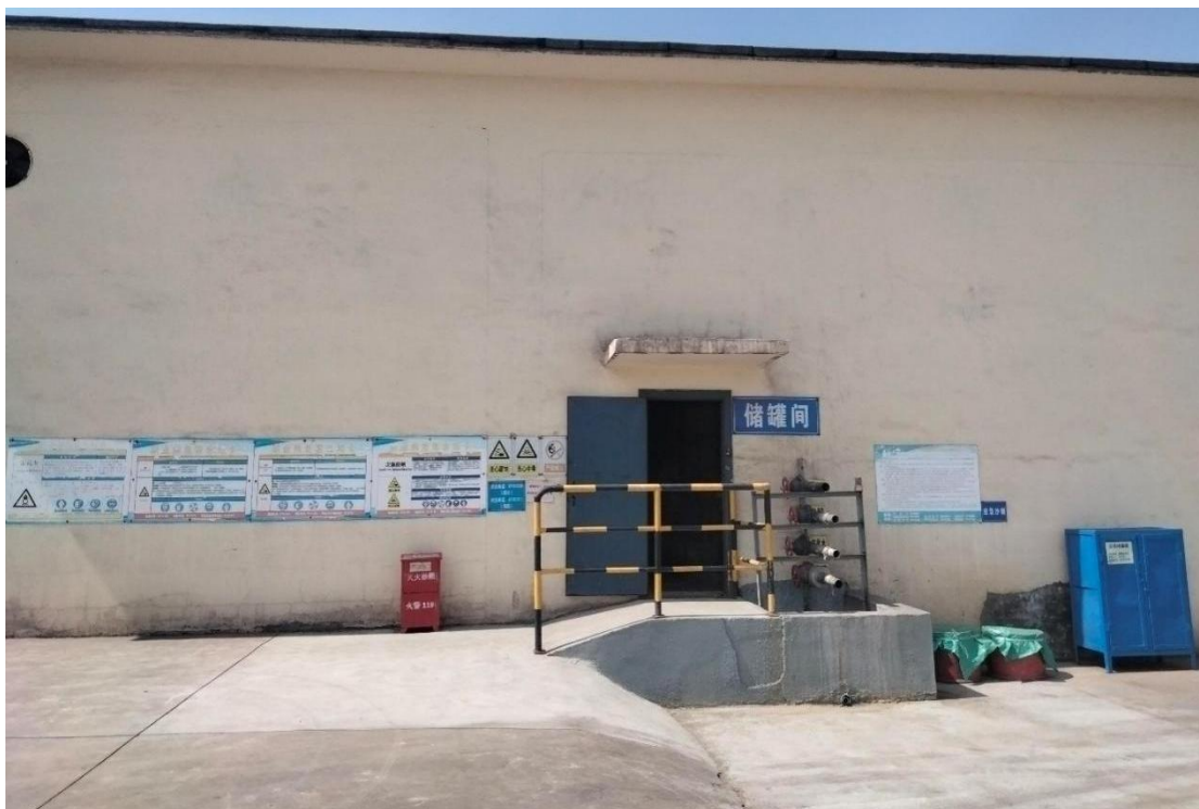
(酚氰废水站储罐间)
