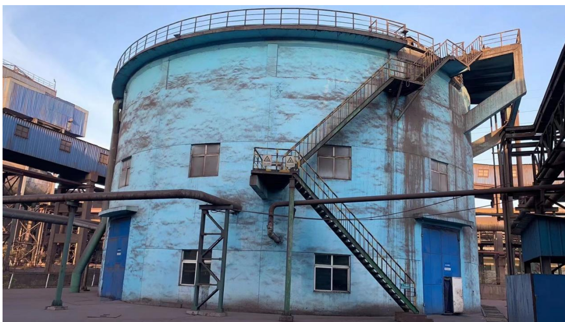
中矿浓缩大井
