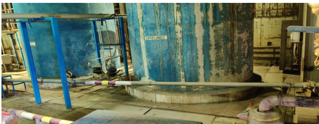
硝酸储罐为接地储罐，罐体设计有阴极保护系统。
