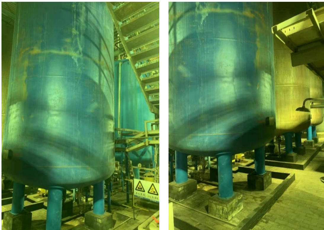
硝酸储罐为接地储罐，罐体设计有阴极保护系统。
