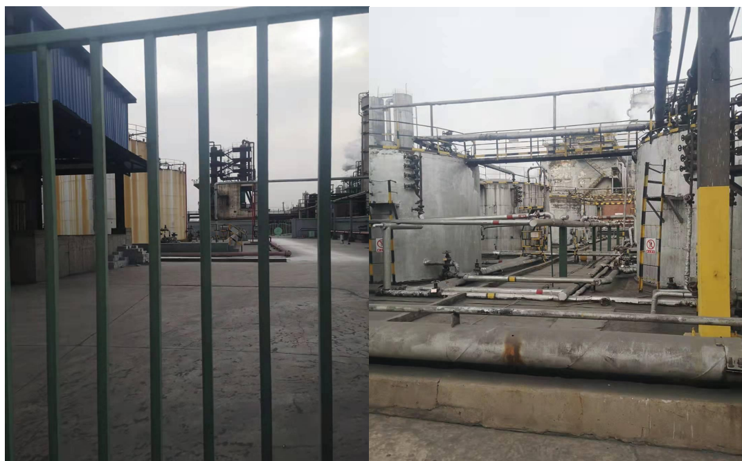
焦化厂粗笨罐区
