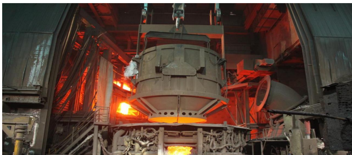
不锈钢炼钢分厂电炉
