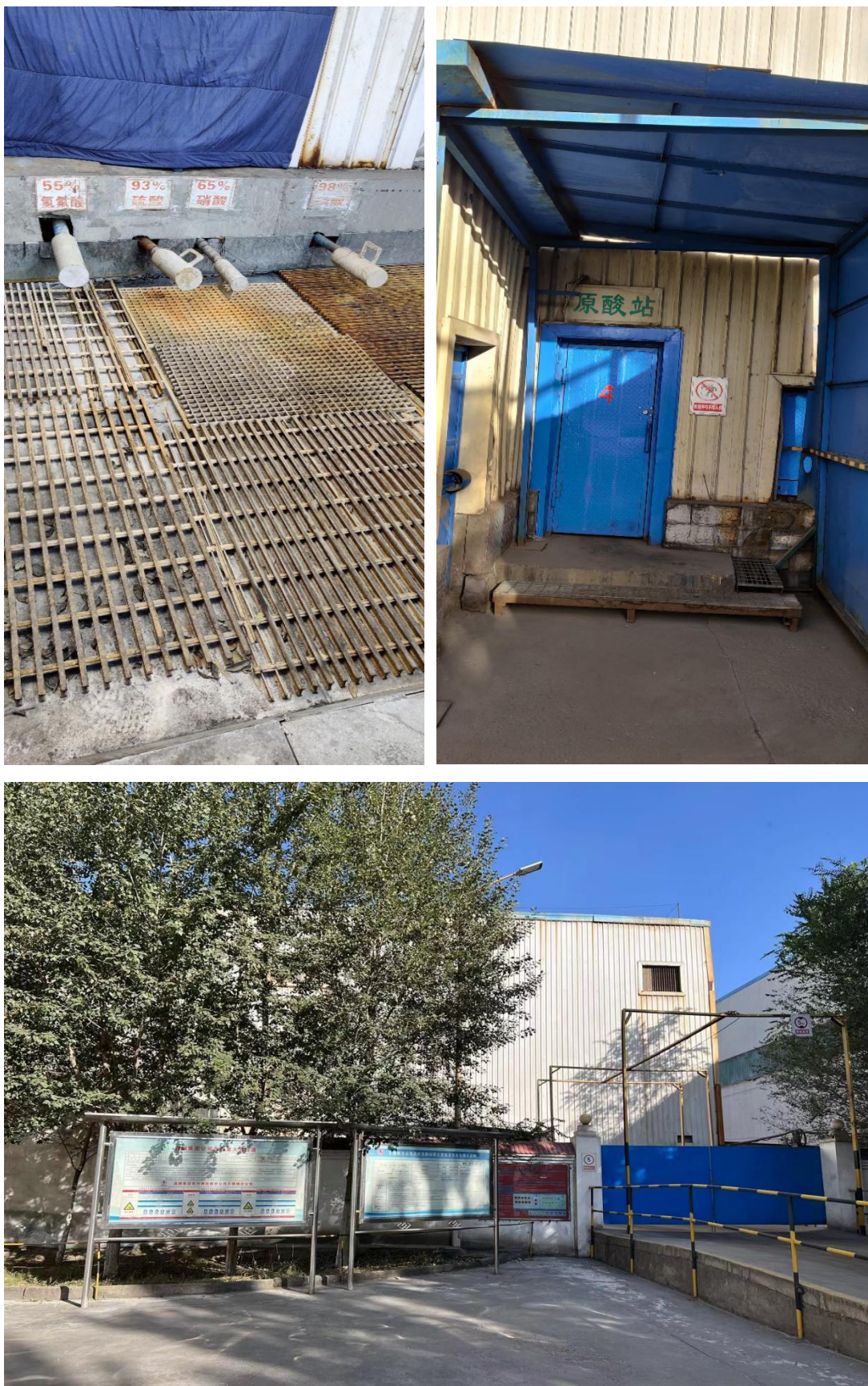
图 3-4 不锈钢厂区原酸站储罐区及装卸点
