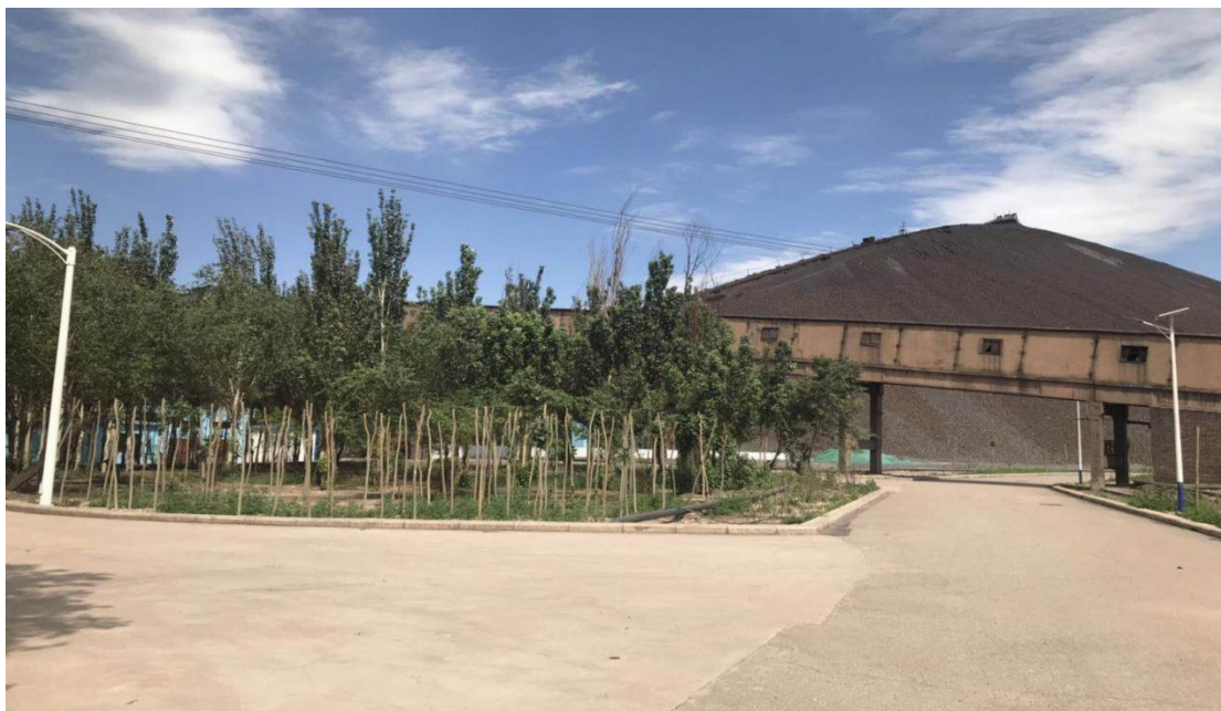
图 3-16 选矿厂废石山现状
