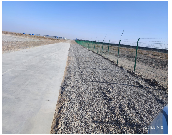
12月进站道路区砾石压盖
