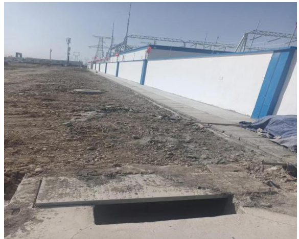
10月站外施工区土地整治措施基本到位
