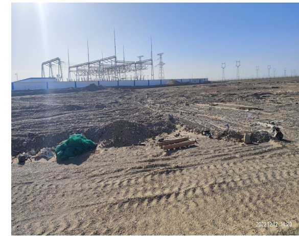
12月变电站区土地整治措施不到位
