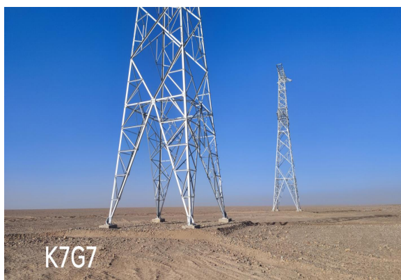
10月塔基区水土保持措施到位
