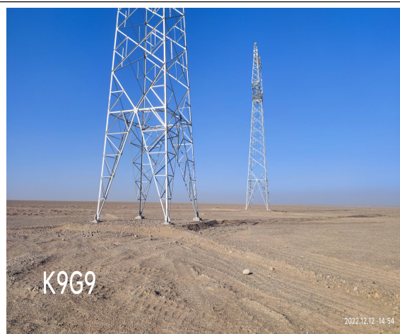
12月塔基区水土保持措施到位
