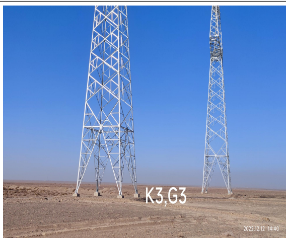
12月塔基区水土保持措施到位
