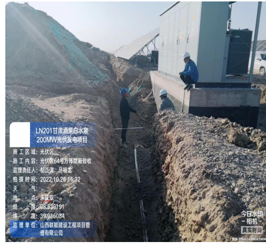
管沟开挖临时苫盖措施
