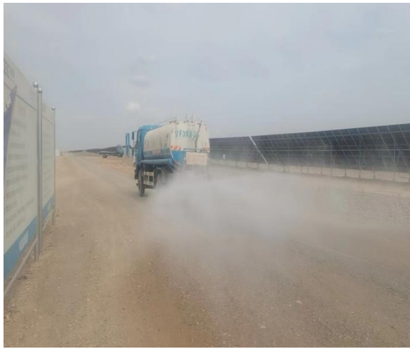
10月厂区道路洒水
