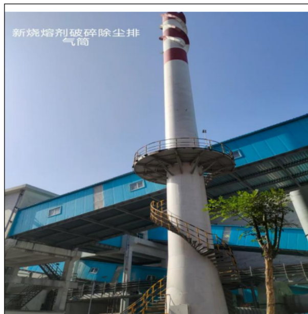
溶剂破碎除尘系统排气筒
