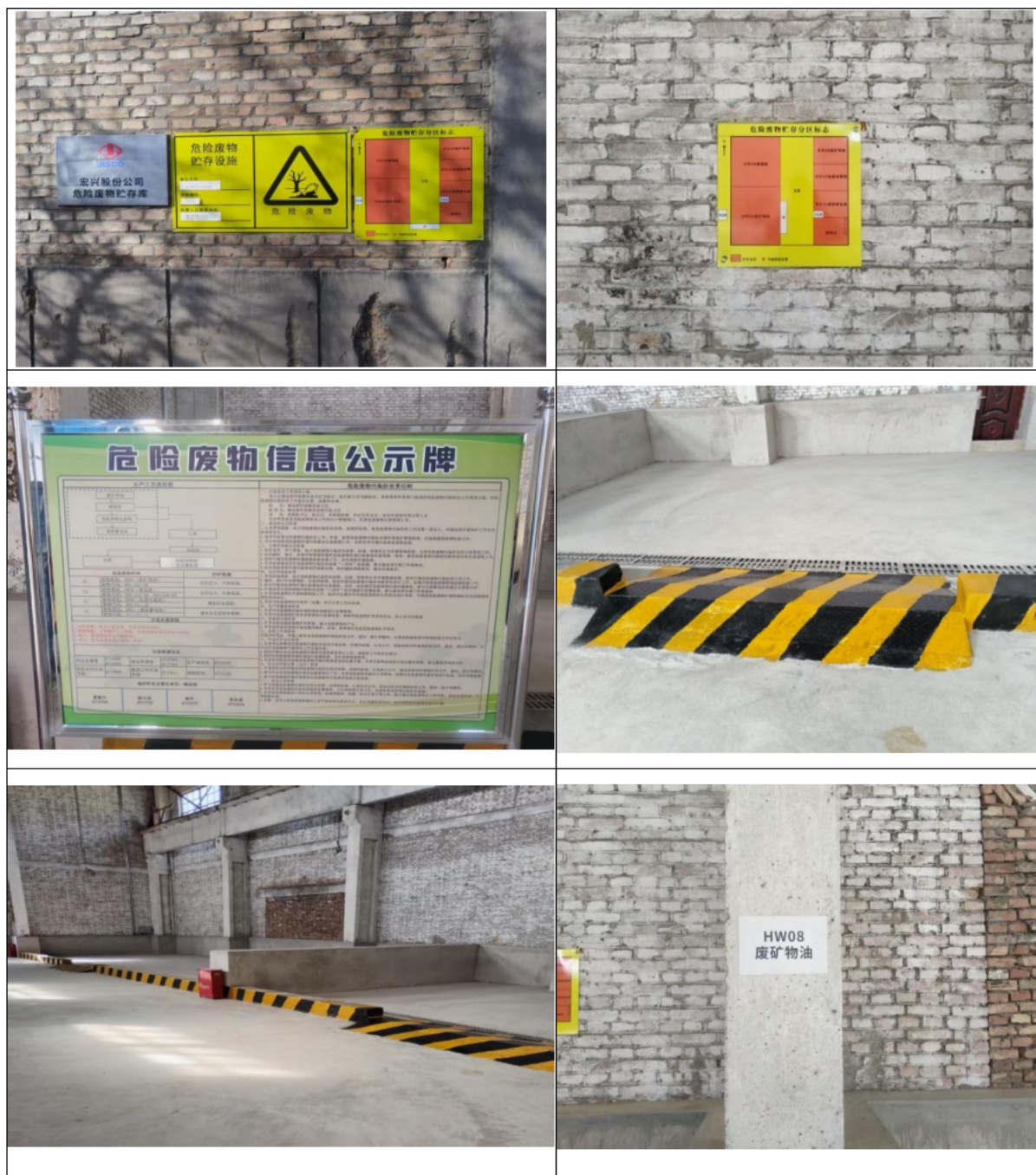
图 4-2 宏兴股份公司危险废物贮存库
