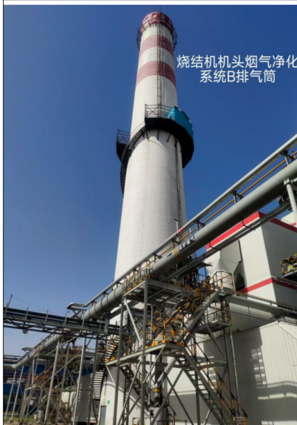
1#烧结机机头烟气净化系统排气筒
