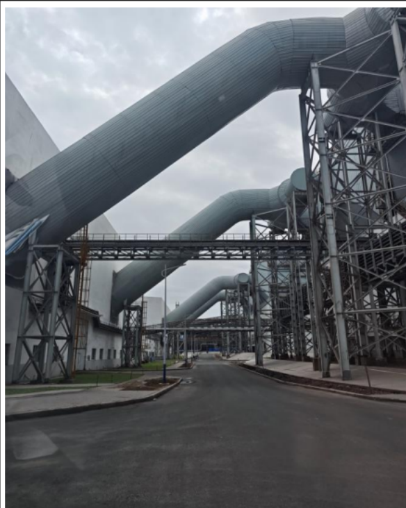
烧结机机头烟气净化系统脱硫脱硝反应
