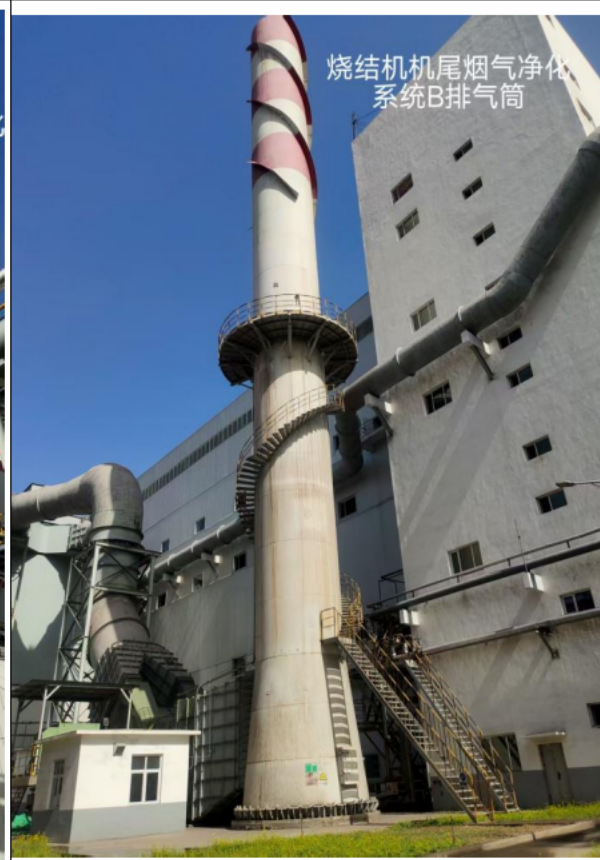
2#烧结机机尾烟气净化系统排气筒
