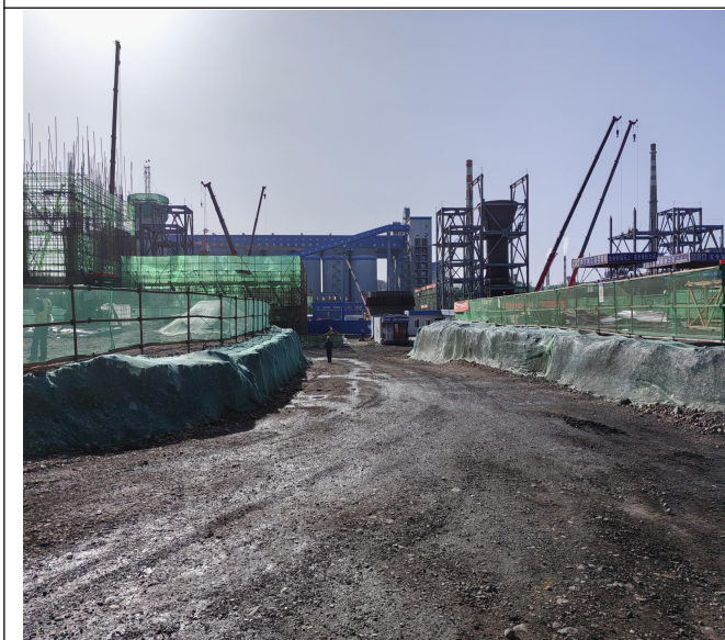
施工期间，采取洒水降尘措施
