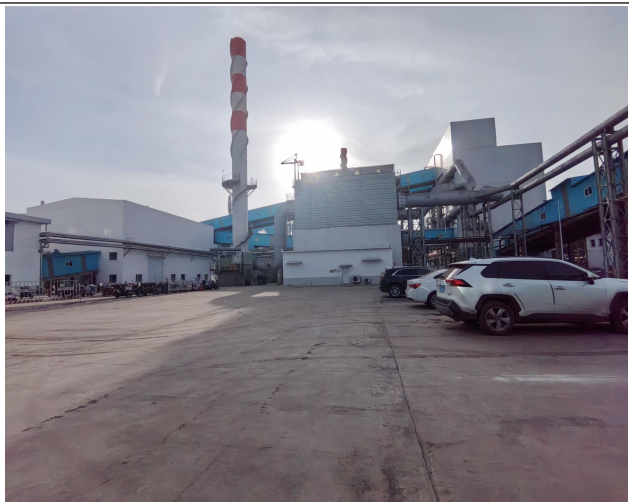
厂区内停车场地面硬化
