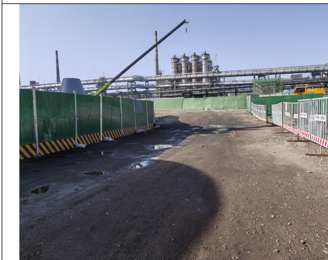
施工期间，厂区内施工采取彩钢板围挡措施
