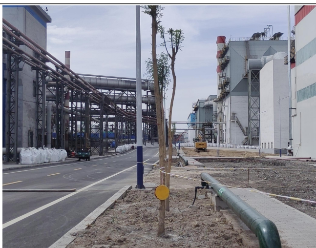
施工期间，采用机械进行土地整治
