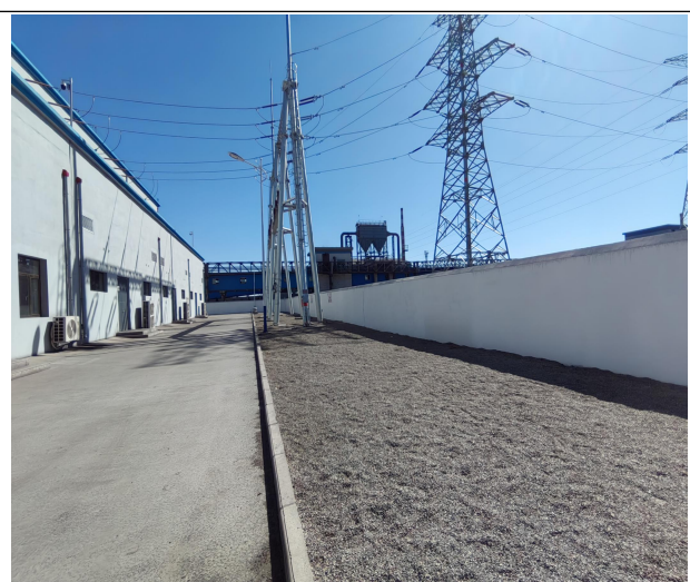
变电站内户外配电设施地面采用砾石铺压
