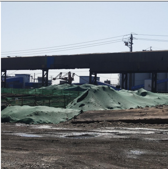
施工期间，厂区内临时堆土采用密目网苫盖
