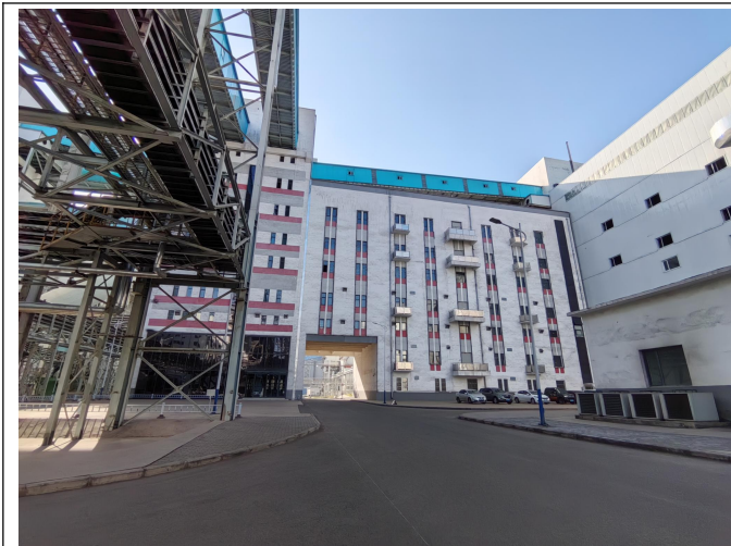
厂区内新建中控室及周边地面硬化
