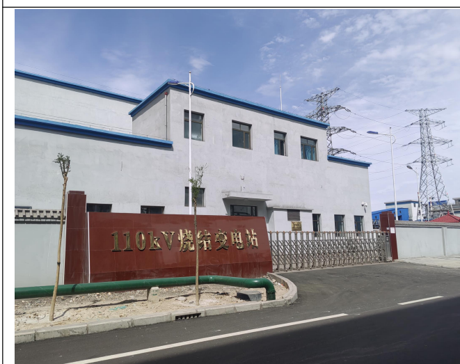
新建 110kV 变电站
