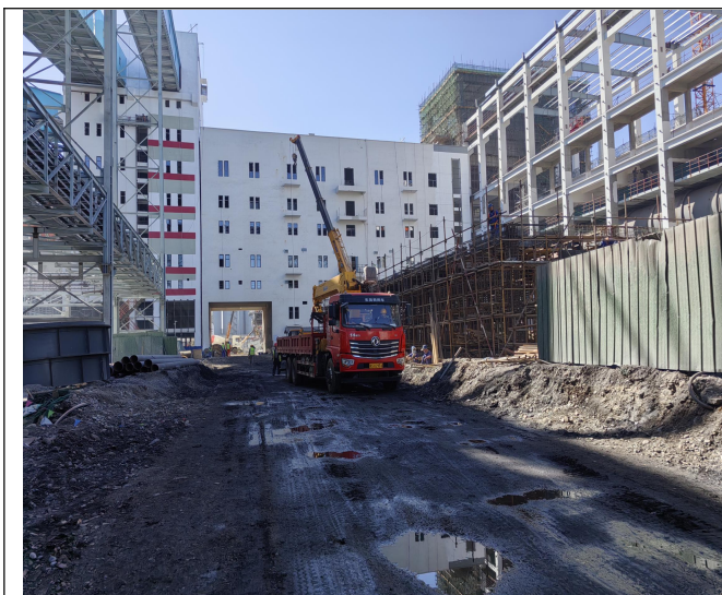
施工期间，厂区内道路采取洒水降尘措施
