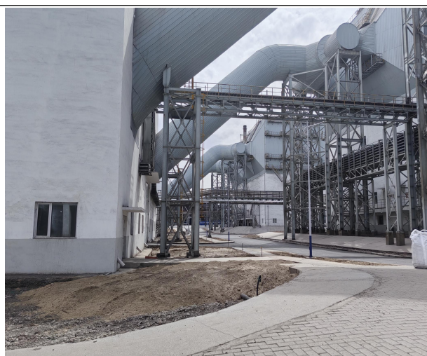
施工期间，景观绿化区域土地整治措施效果
