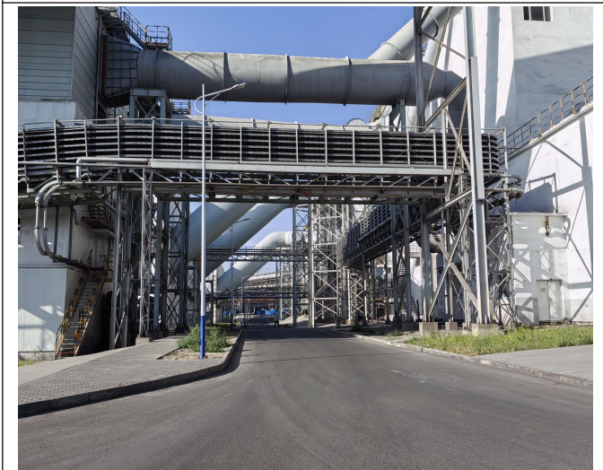
厂区内道路硬化
