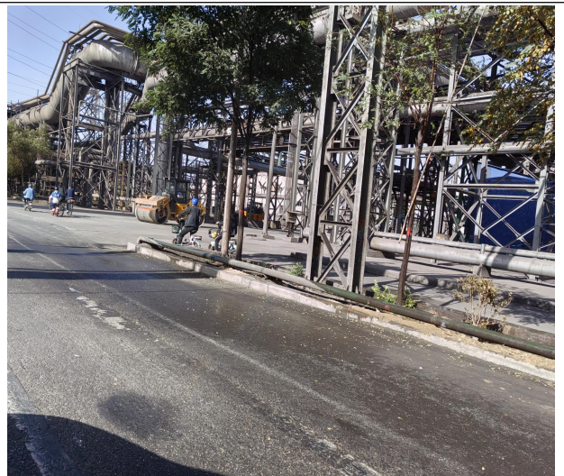
输送系统建成后地面恢复硬化
