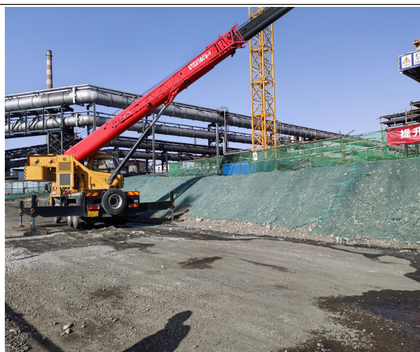
施工期间，裸露边坡苫盖密目网
