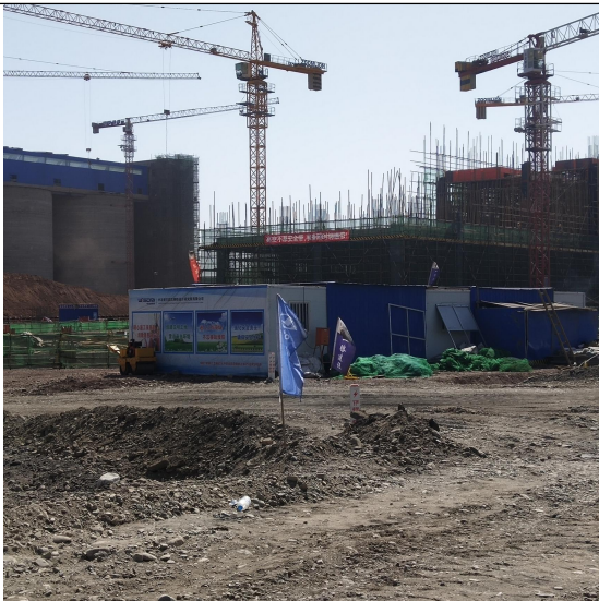
施工期间，施工场地内设临时施工办公区，施工后期恢复项目用地功能
