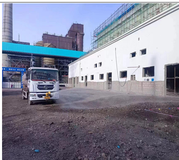
施工期间，变电站内采取洒水降尘措施
