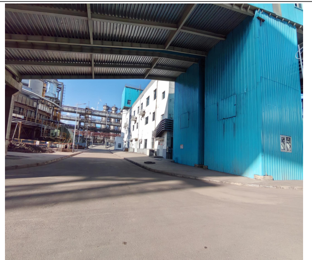
厂区内道路硬化
