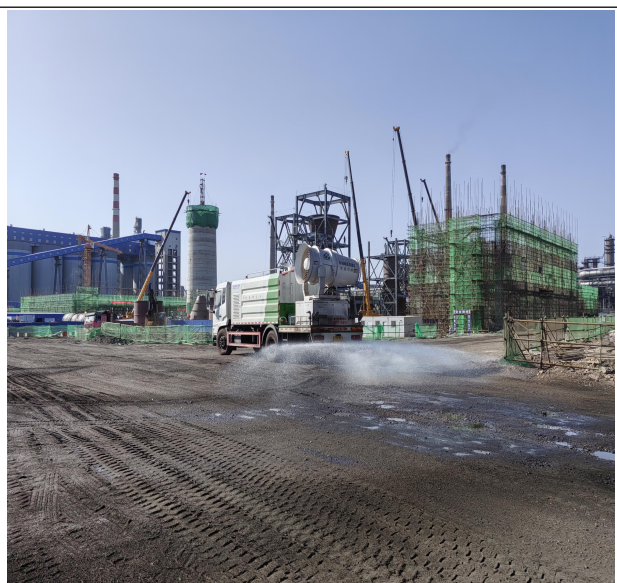
施工期间，采取洒水降尘措施
