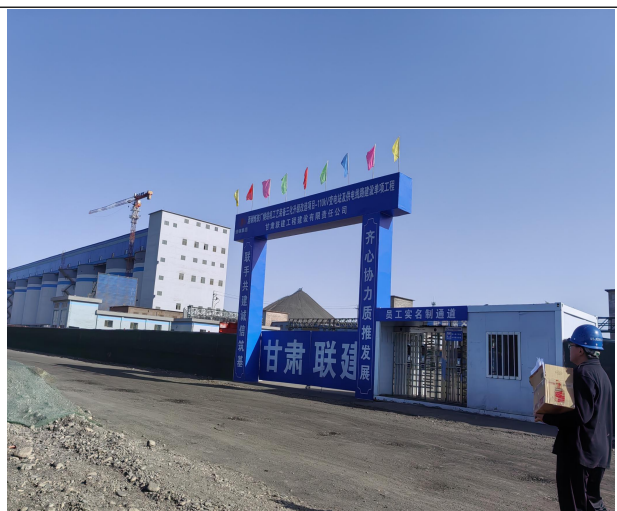
施工期间，变电站施工采取彩钢板围挡措施
