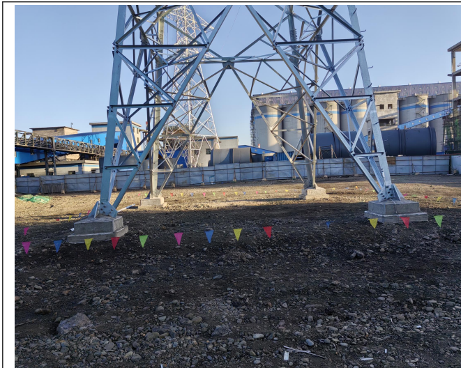
塔基施工场地采取土地整治措施
