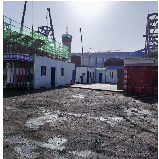
施工期间，施工场地内设临时施工办公区，施工后期恢复项目用地
