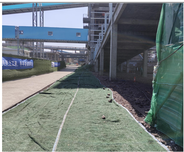
施工期间，厂区内裸露地面采用密目网苫盖
