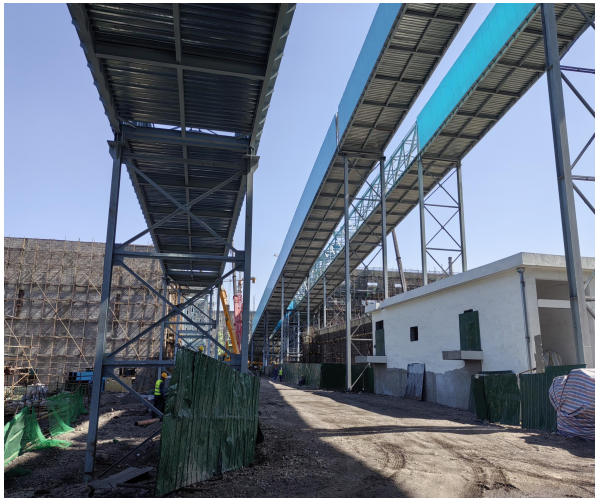
物料输送系统区采取彩钢板围挡措施（2024.3）
