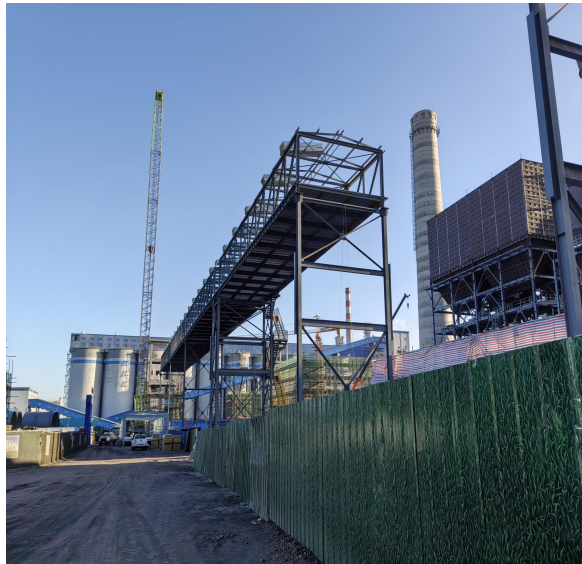
生产厂区内采取彩钢板围挡措施措施 (2023.11)
