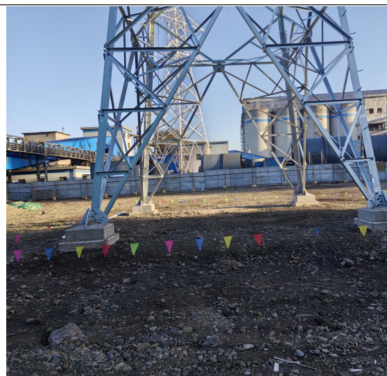
塔基施工场地采取土地整治措施
