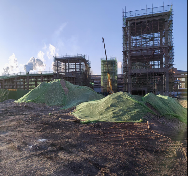
生产厂区内采取临时堆土措施措施（2023.11）
