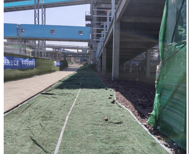
生产厂区内采取裸露地面苫盖措施（2024.3）
