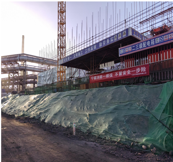
生产厂区内采取裸露边坡苫盖措施（2023.11）
