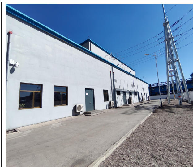
变电站内采取砾石压盖措施
