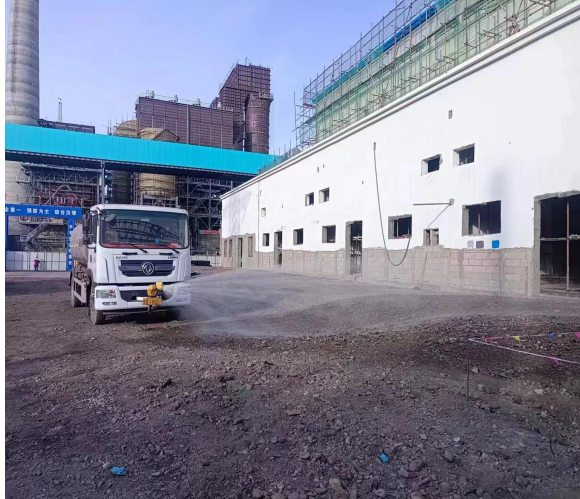
变电站内采取洒水降尘措施（2024.3）
