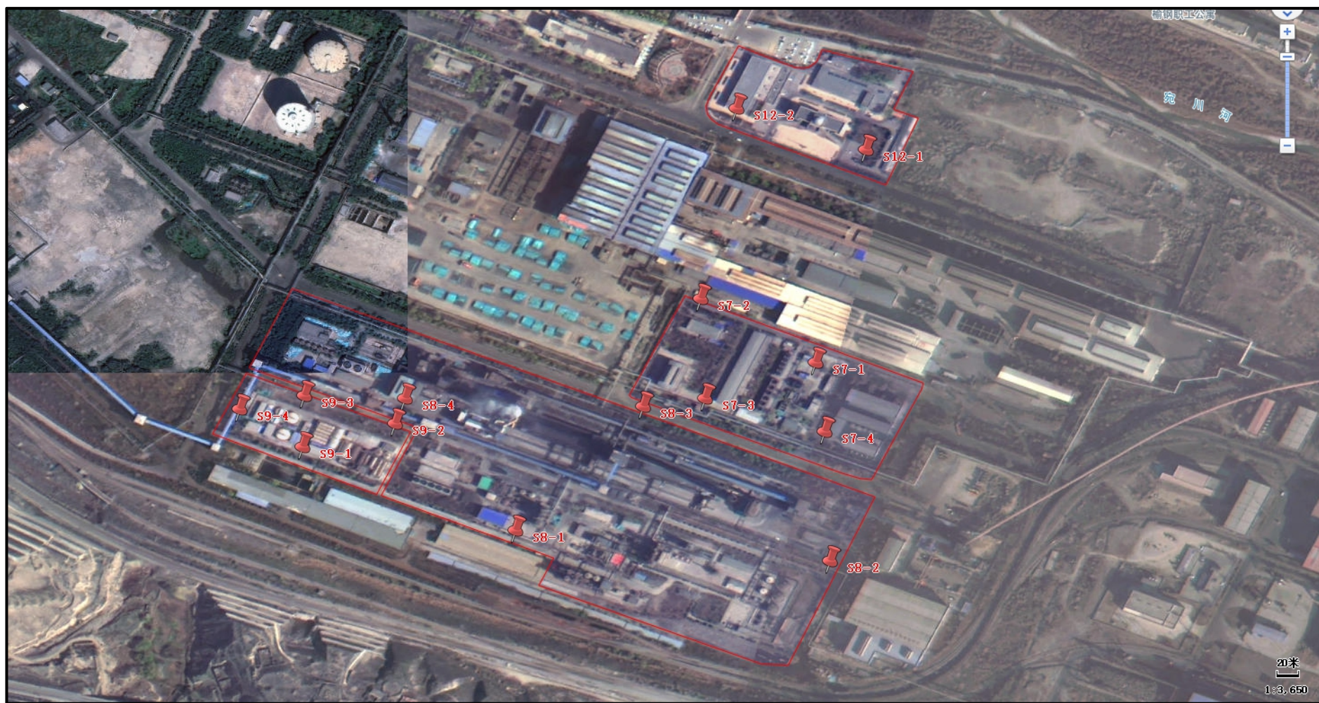
图 4 榆钢场地现状调查监测点位图(S8：焦化工序、S9：酚氰废水处理站、S7：二期污水处理厂、S12：办公楼)
