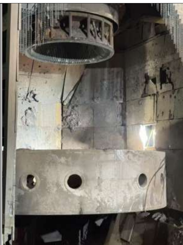
3#转炉拆除照片
