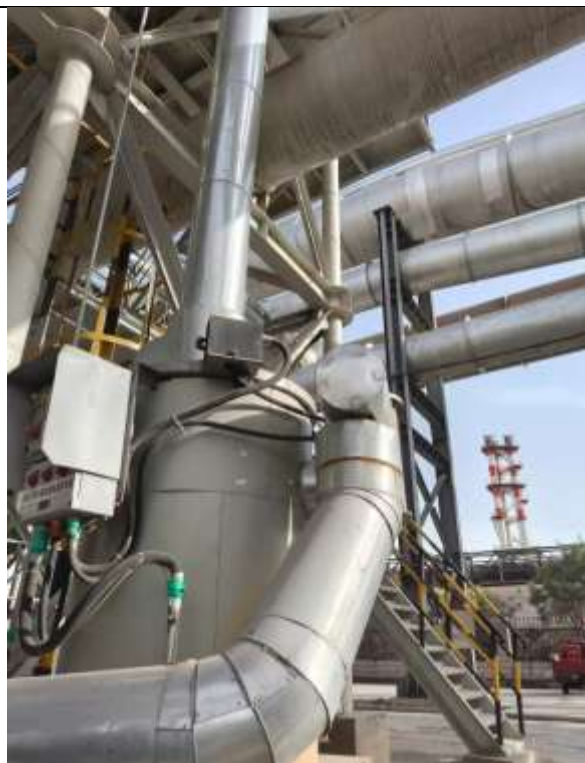
输气管道设置水封装置
