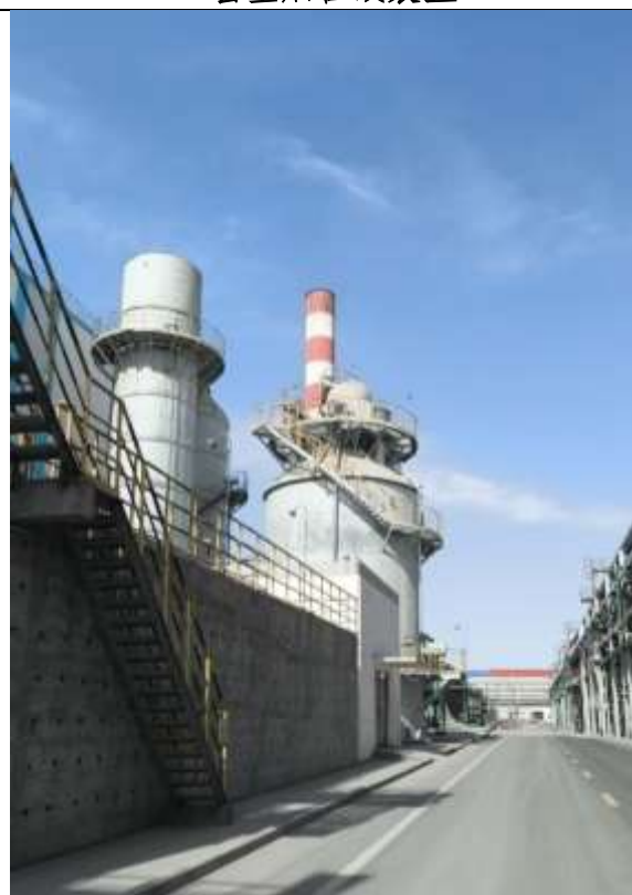
钢渣处理辊压区除尘系统排放口 (DA322)
