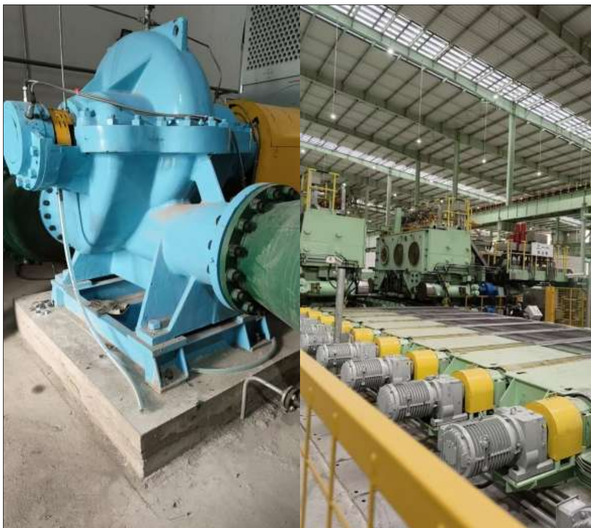
泵体金属波纹管软连接、基础减震
