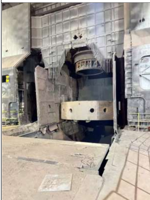
2#转炉拆除照片
