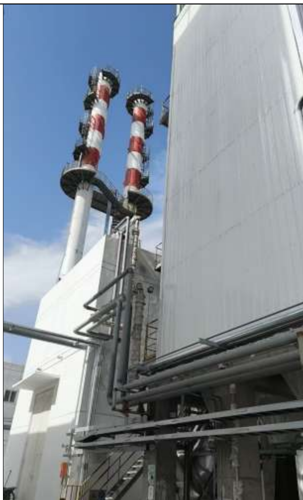
加热炉空烟和煤烟排口
