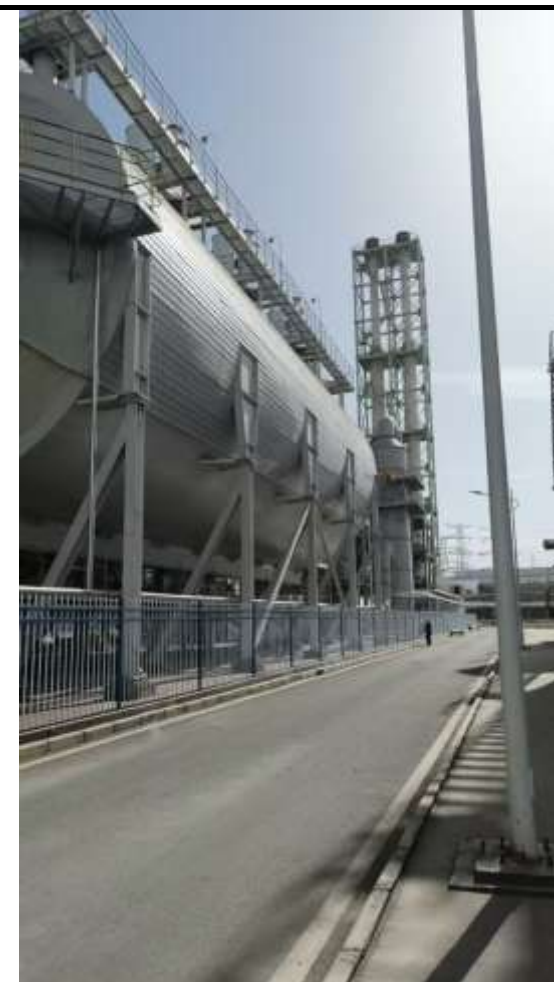
1#和 2#转炉一次烟气两根 64m 放散塔
